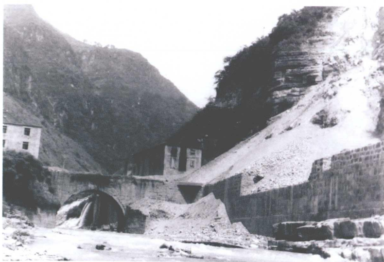
1986 年,关河电站二车间建设场景
