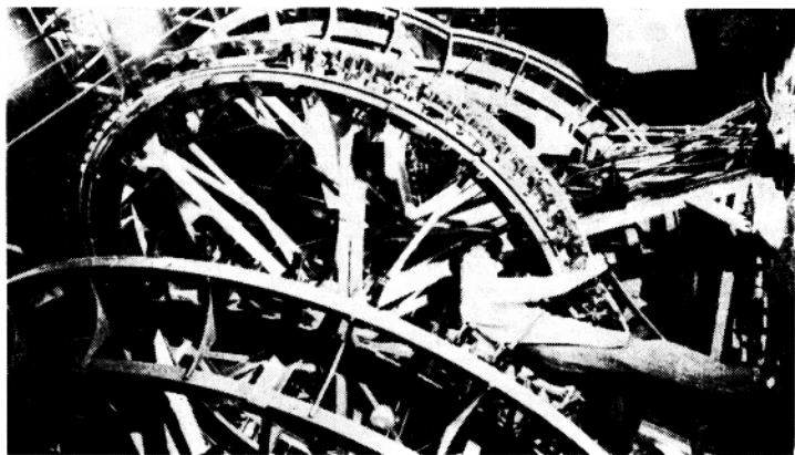
1-8 “先锋”号飞机车轮式隔框夹具正在安装
