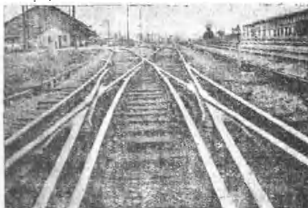
照片3：于1958年4月5日在该道岔上（4041/9四开道岔） 的钝角辙叉有害空间处，X 00 -539012号货车第三 位轮缘与心轨右股鼻端相撞曾发生过进入异股而脱 轨事故。
