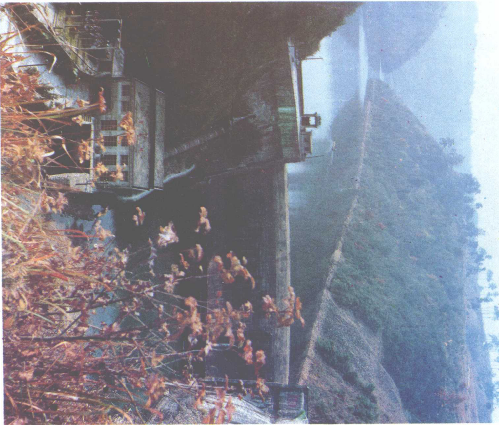
拦河筑坝，人造平湖，八舟河被拦腰截断建成电站，装机容量二千瓩。
