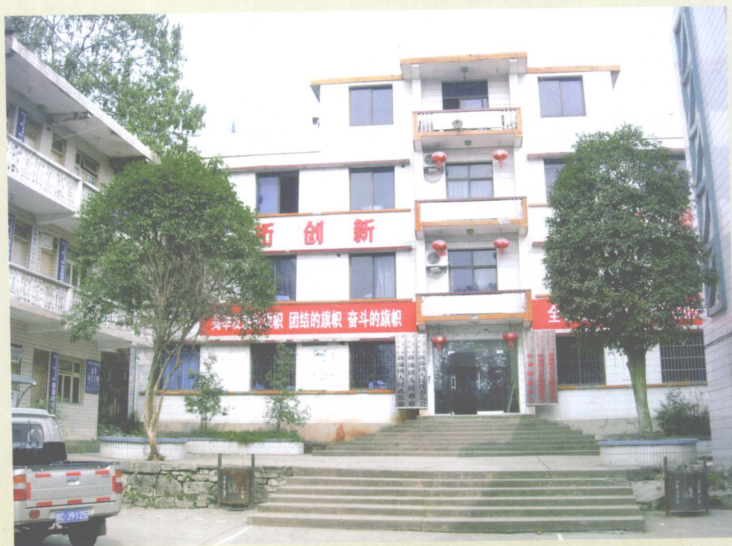
新蒲镇人民政府办公楼(2009 年)
