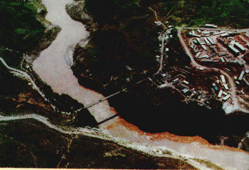
东风电站施工现场鸟瞰
