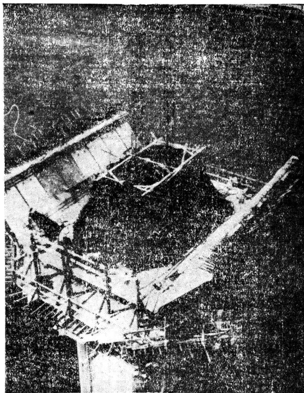
图12 胶板预制现场组装的施工方法
