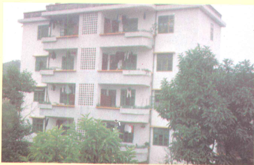
广宁县坑口医院宿舍大楼
