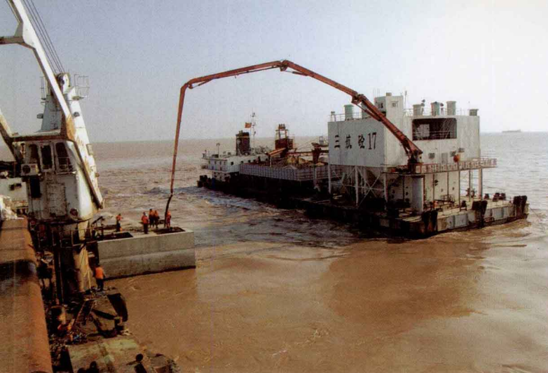
混凝土搅拌船浇注灯桩承台
