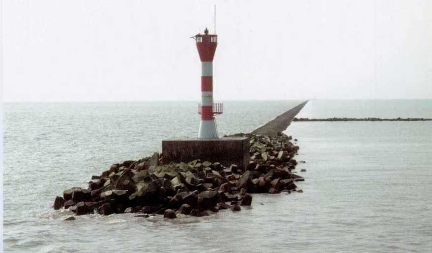
雄伟的南导堤堤头。由此往上至分流口，导堤延伸 48.077 公里。
