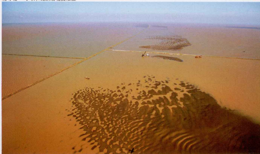
北导堤 N5 丁坝和促淤潜堤交汇区
