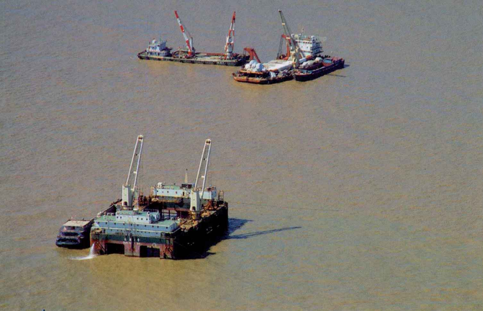
铺排、抛石和整平
