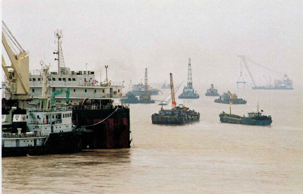
北导堤施工场景
