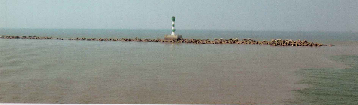
北导堤堤头及灯桩。由此至横沙岛，导堤蜿蜒 49.2 公里
