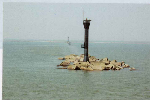
北导堤 N10 丁坝，长江临海第一座丁坝。
