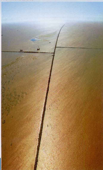
向东延伸的北导堤
