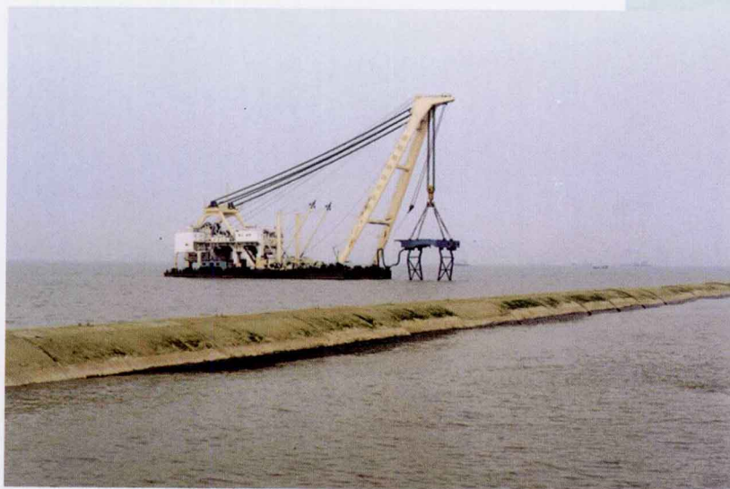
充砂半圆体混合堤（单个重量 450t）
