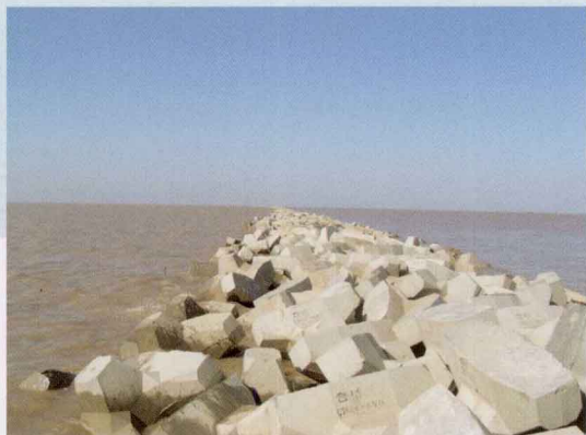
袋装砂堤心钩联块体护面斜坡堤
