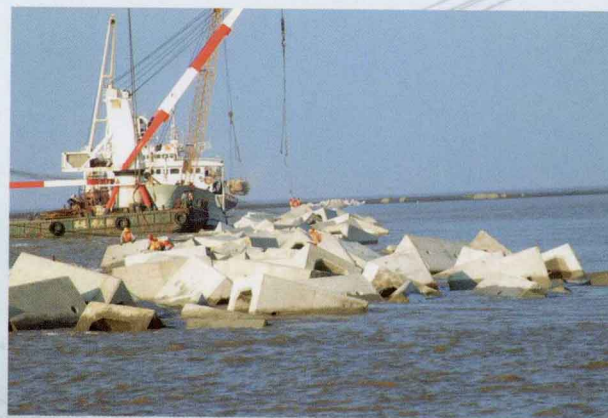
单个重量为 19t 的空心方块斜坡堤。两面空心，主要用于丁坝。
