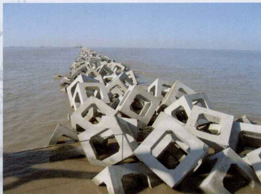
单个重量为 14.4t 的空心方块斜坡堤。六面空心，主要用于导堤。
