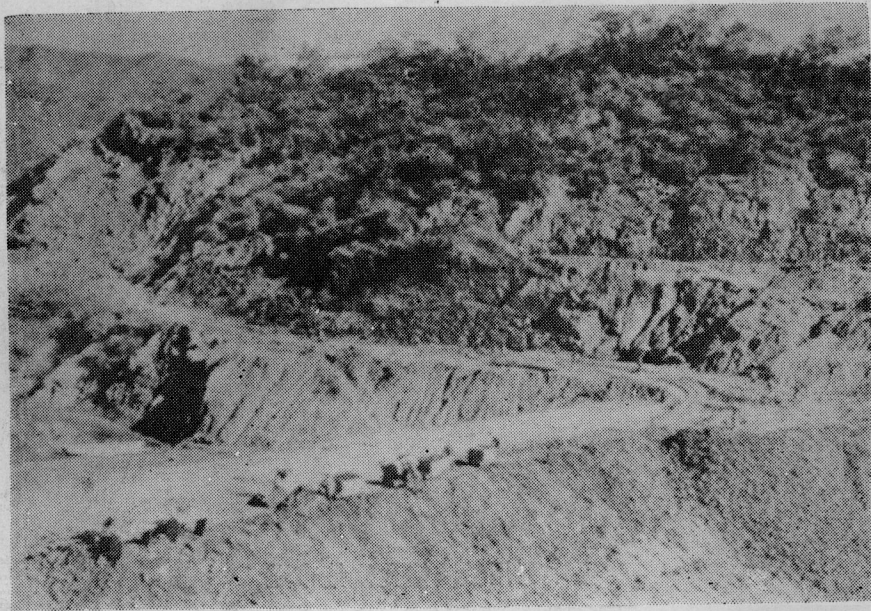
嘉南大圳修復工程開工情況
