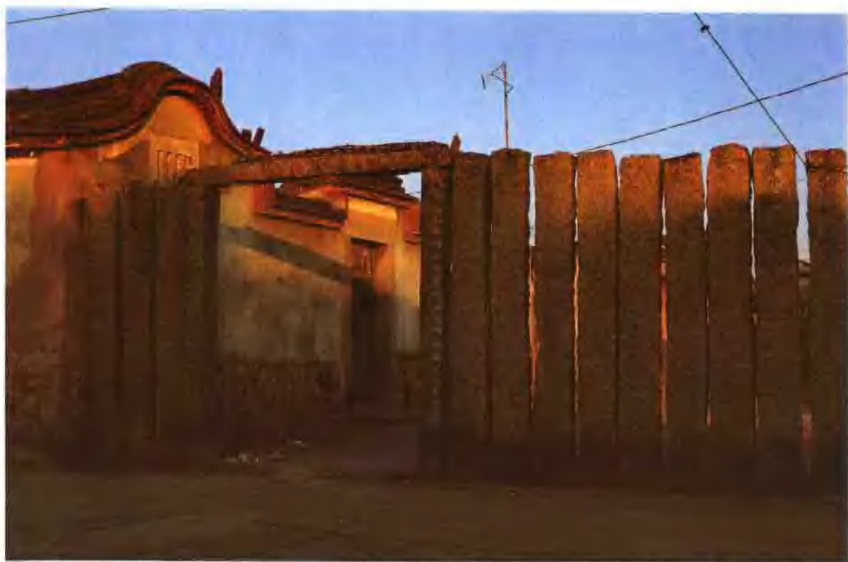
△後浦某民宅前院以巨大的花岡石條為牆，將石條直接插入土中，入口處置橫楣。石材未經細琢，反而呈現樸拙雄壯之美。
