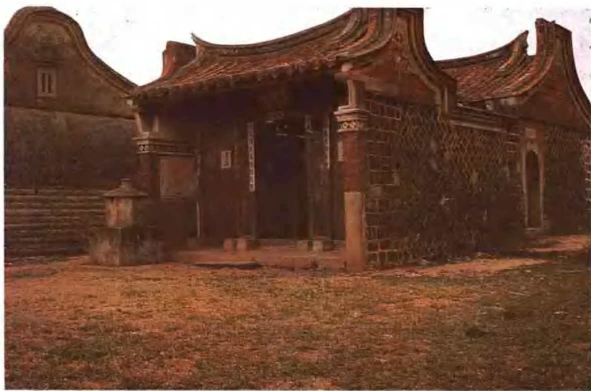
△瓊林忠義廟，金門的小廟多採單開間格局，正殿前帶拜亭，屋頂前後相接，屋脊(規帶)連成和緩之曲線。正脊除燕尾外，再將封火山牆突出天空，作成八字規。
