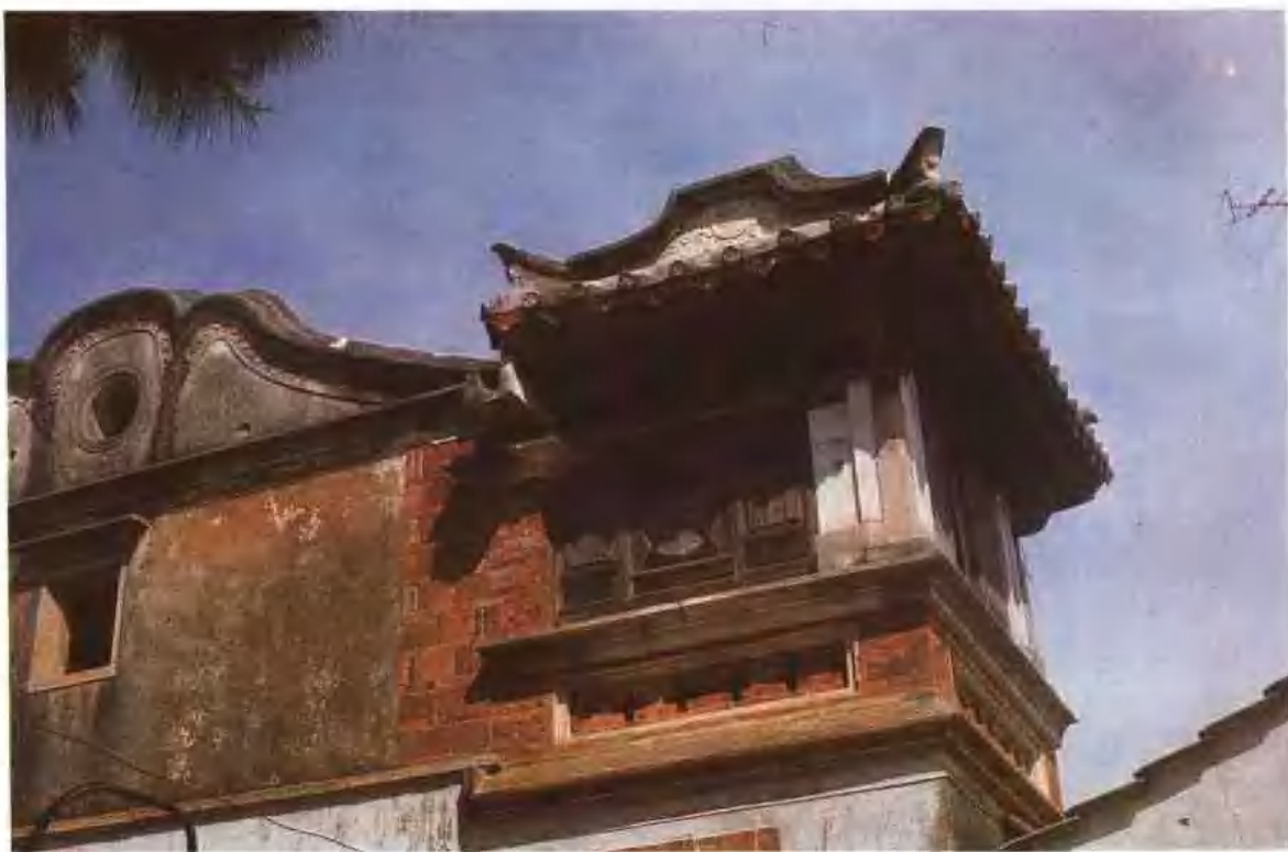
△小徑蔡宅廂房上的精美閣樓，歇山單簷頂，木造結構，牆上開圓洞窗。整體形式玲瓏秀麗，作為修身養性之所，又稱為書樓。
