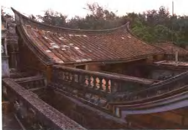
△水頭村蔡宅合院之屋頂景觀，廂房作成平頂以便晒雜糧。正堂屋頂內加設夾層，可當貯藏室，充分利用空間。金門之合院廂房常作成平頂，圍以短欄杆。
