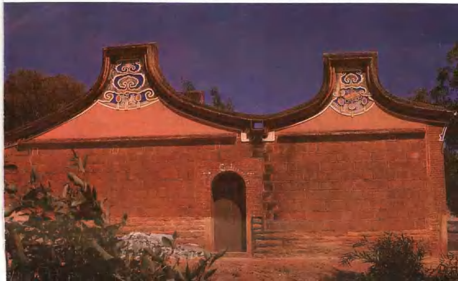
▽後盤山威濟廟，正殿與拜亭均施八字規山牆，前後屋頂之間設排水槽，雨水導至規帶下方之落水口流出。鵝頭泥塑裝飾造型渾厚，色彩華麗。廟雖小，但頗具威武氣勢。
