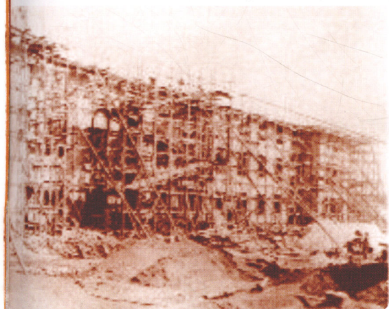
图3 1953年开工建设新校舍时的施工现场
