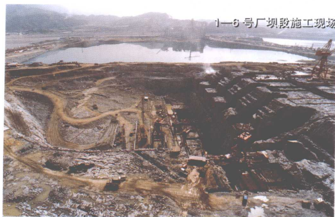
三峡工程二期围堰基坑
