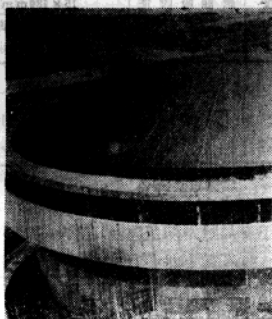
图4 费拉拉布市一建筑物圆顶防水
