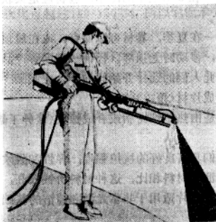
图8 冷沥青与玻璃纤维同时喷涂
