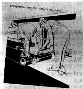
图11 DeRbigum防水卷材火焰粘结
