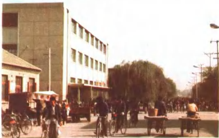
县城东门外大街，现改称淑阳大街修建于1985年6月
