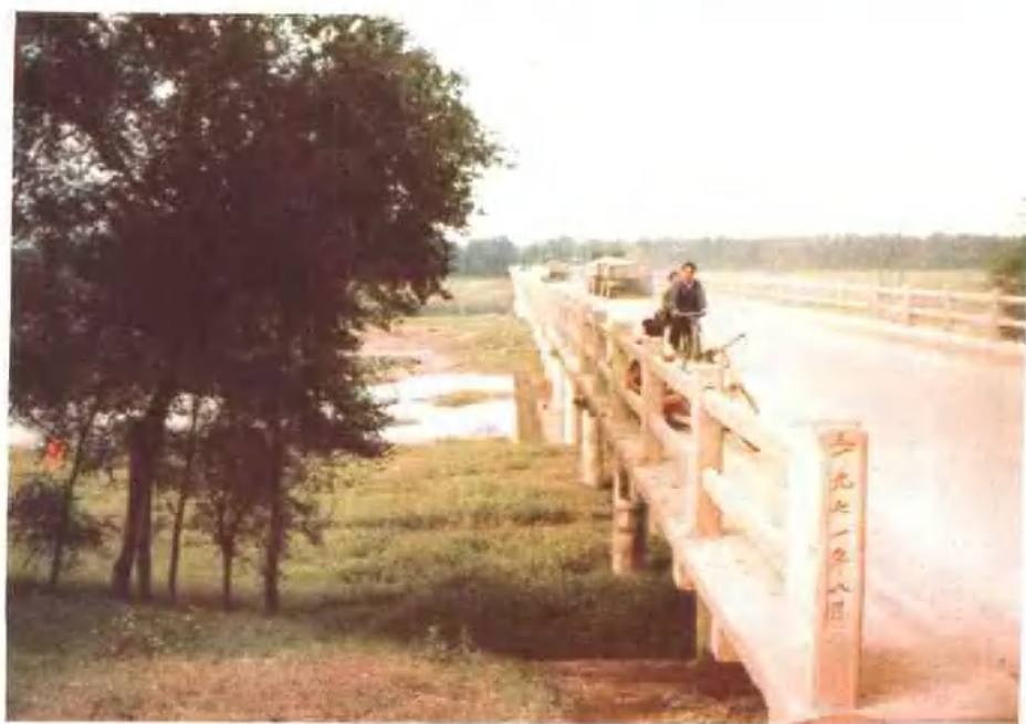
通唐线潮白河义井大桥 修建于1971年8月
