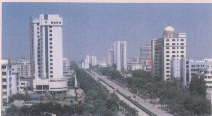
城市建设，欣欣向荣。图为湛江经济技术开发区建设新貌（郑锋摄）
