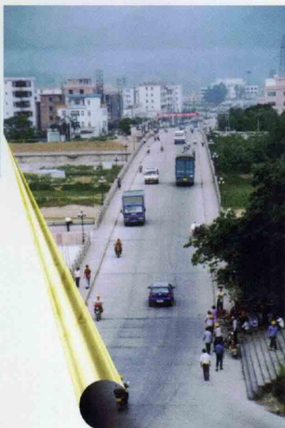
维修加固后的独岗大桥
