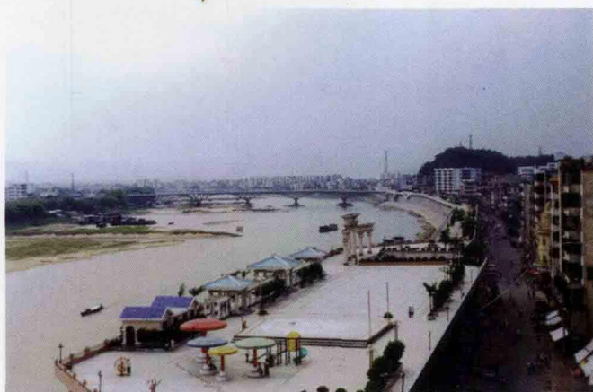
集防洪、娱乐、休闲、商贸于一体的江滨堤园
