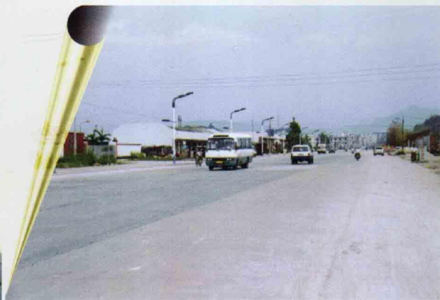
▲ 扩宽改造后的仓丰大道
