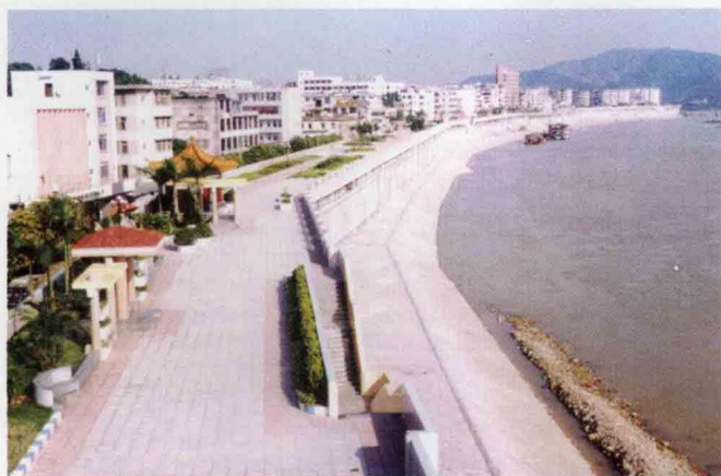
加固后的西堤园
