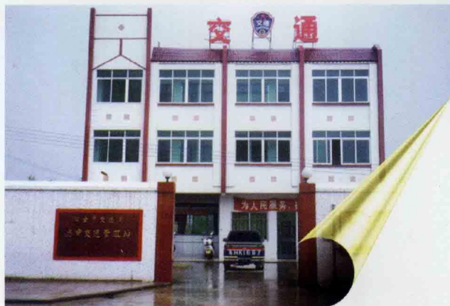
▲ 新建的龙甫交通管理站办公楼
