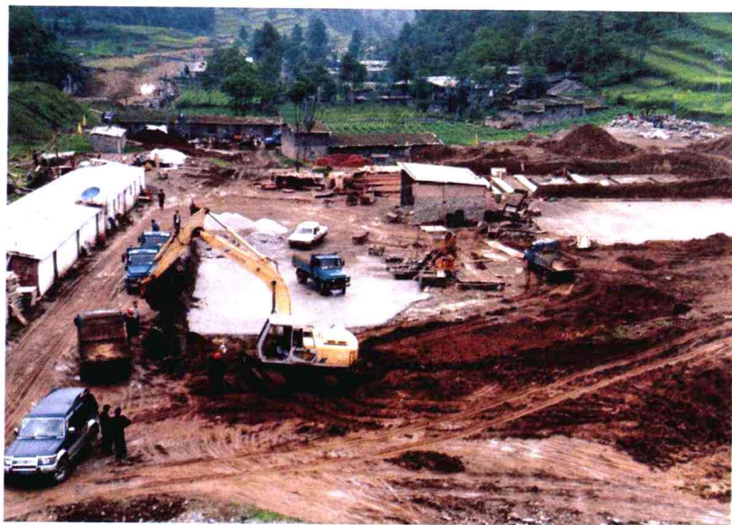
施工中的县城供水工程
