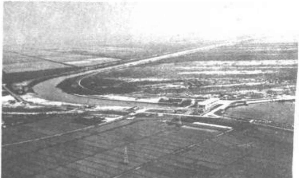
▲南部排水機場中央幹線排水路
