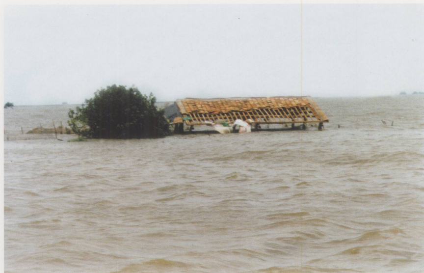
肆虐的洪水呼啸而至，漫过龙滚河大堤，浸进了龙滚镇村庄
