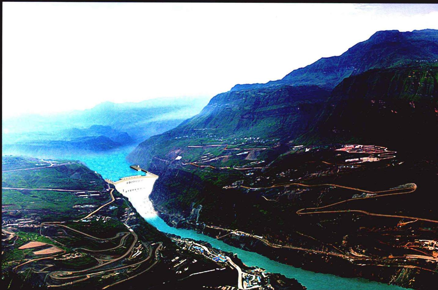
溪洛渡水电站是金沙江开发的第一期工程之一，坝址位于云南省永善县和四川省雷波县相接壤的溪洛渡峡谷，下游距宜宾市河道里程 184 千米，距离三峡、武汉、上海的直线距离分别为 770 千米、1065 千米、1780 千米，是一座以发电为主，兼有防洪、拦沙，改善下游河段通航条件等综合利用效益的巨型水电站。电站的坝址以上流域面积为 45.44 万平方公里，坝址多年平均流量达 4570 平方米 / 秒，其最大坝高为 278 米，正常蓄水位 600 米。总库容达 115.7 亿立方米，调节库容 64.6 亿立方米。电站装机容量为 1260 万千瓦，总施工期为 12 年半。
