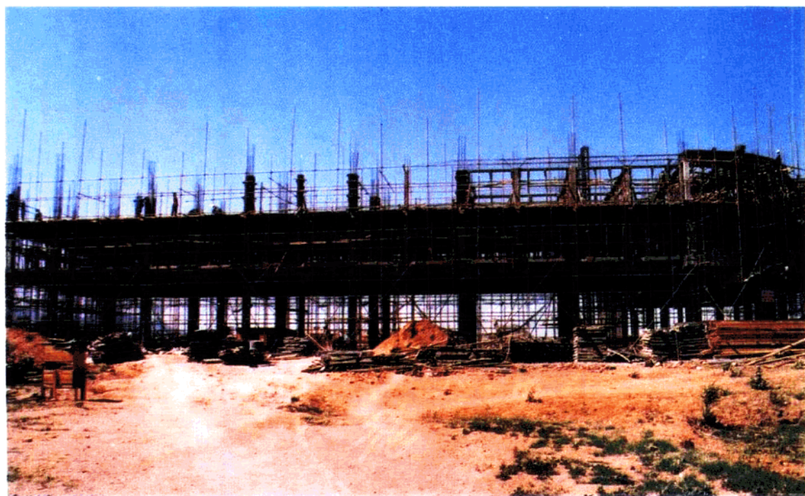
建設中的香港大雄房地產公司寫字樓
