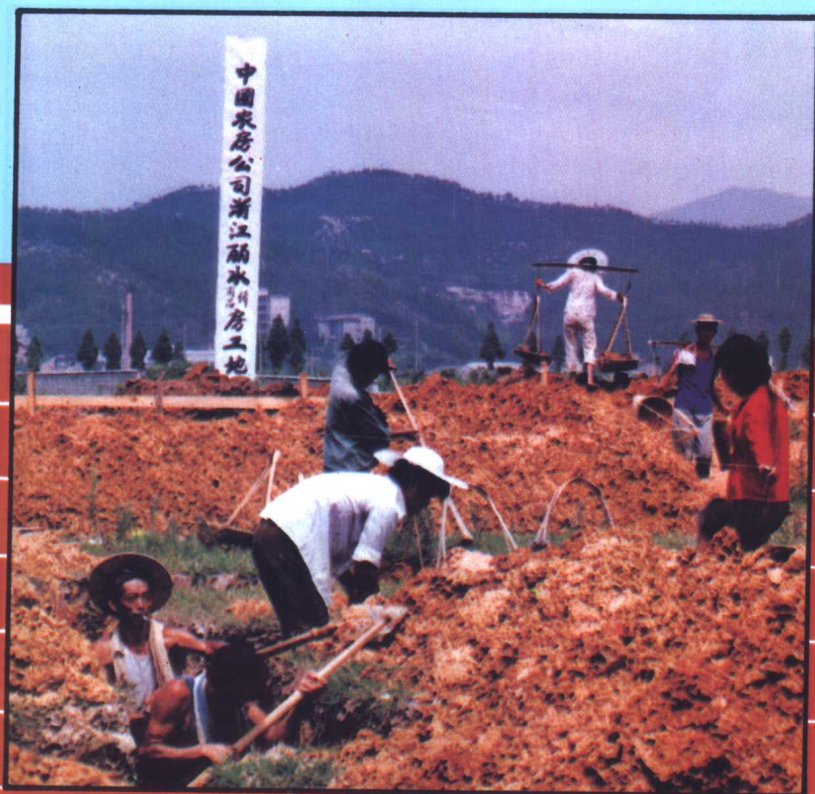
中國農房公司浙江省麗水商品僑房工地破土動工。
