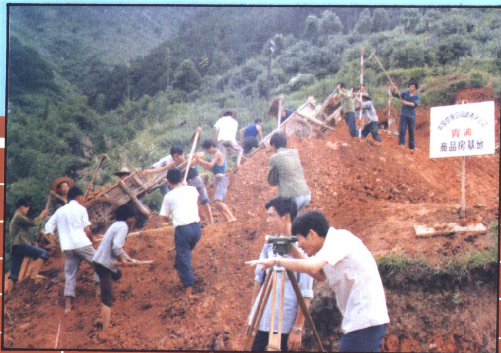
中國農房公司武夷公司認真勘測、規劃， 節約每一寸土地，利用山坡地為農民建房。
