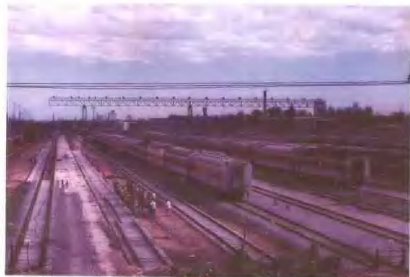
1996年随着空调旅客列车的开行, 客技站整备线已不能满足列车库检作 业要求图为客技站原预留线18、19、 20道增设施工现场 (邢连群提供)
