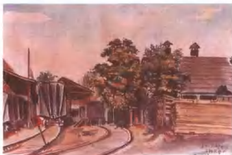
1953年6月，我段第一次新建的竹杆席棚顶 货车库。（图为车库南头）
