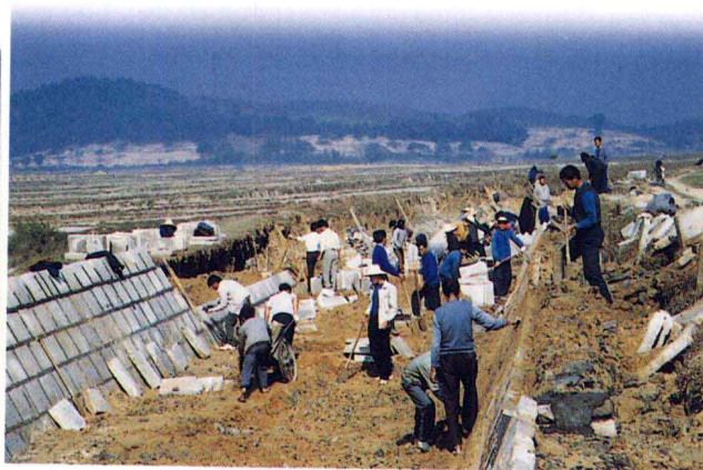
本县最大引水工程马宁水渠在进行水泥板铺设三面光硬底化改造。
