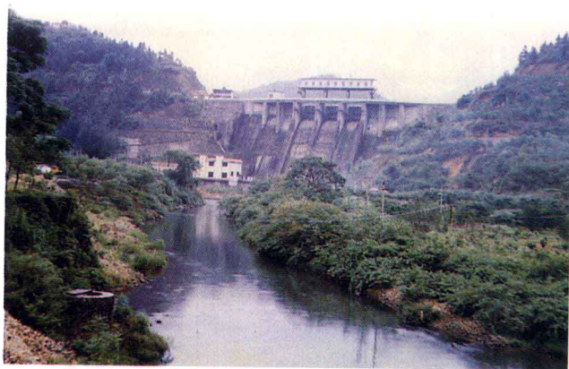
下竹水库库容 5300 万立方米,是本县最大水库,灌溉面积 12 万亩,坝后电站装机 4000 千瓦。1997 年开始“一库制”水库建设。图为下竹水库大坝。
