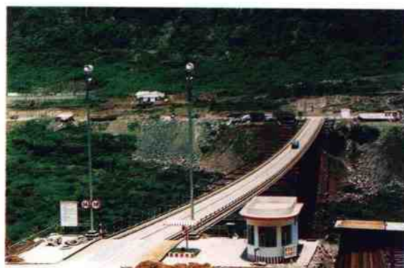
溪洛渡电站施工区还建桥（夏延安摄）
