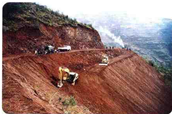
正在建设中的乡村公路 (2003年12月) (龚志海 摄)
