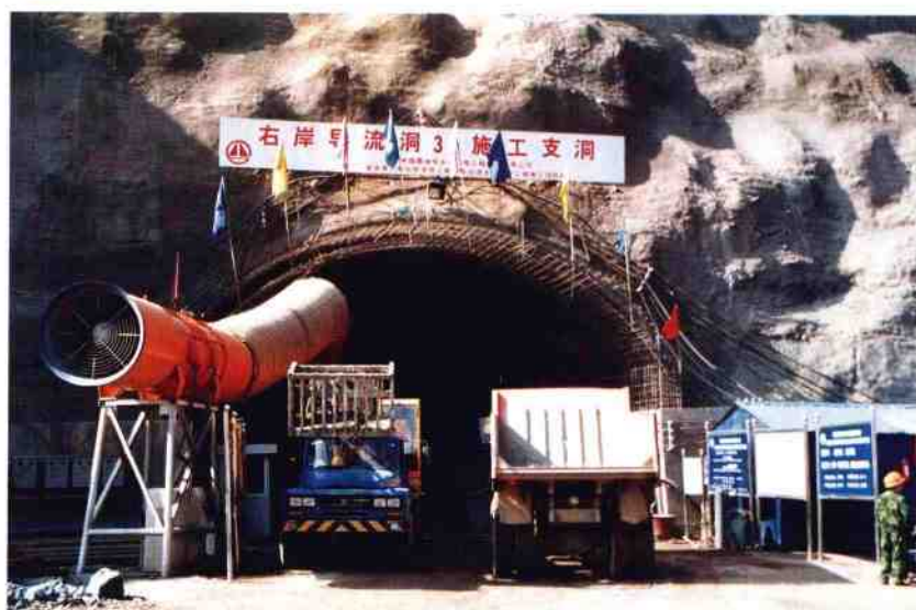
正在建设中的溪洛渡电站右岸导流洞3号支洞施工现场（贺霖摄）
