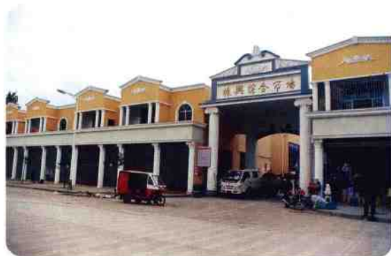
县城综合农贸市场竣工 (2004 年 8 月) (夏延安 摄)
