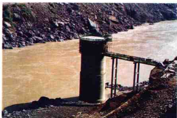
溪洛渡电站施工区抽水系统正在建设（贺霖摄）
