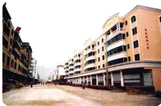
即将竣工的永善振兴大街欧寓建筑 (2004 年 11 月) (夏延安 摄)
