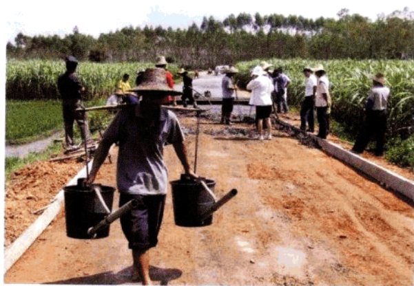
●乡村道路施工现场
