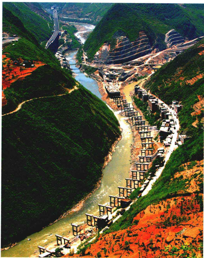
古道新貌——建设中的水麻高速公路
