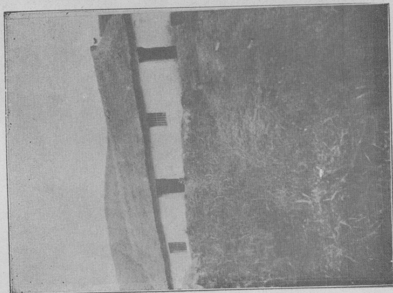
第一林場第二區徐白第二區分區舍
