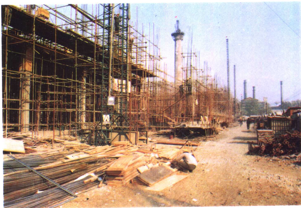
建设中的 500 吨浮法玻璃示范线
