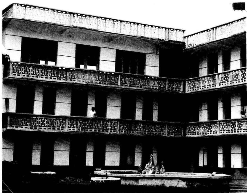
地瓜区复退军人建筑队承建的楼房之一
