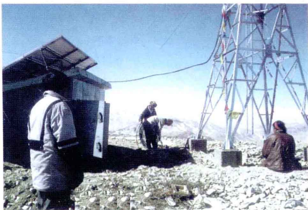
铺电信光缆线一角
