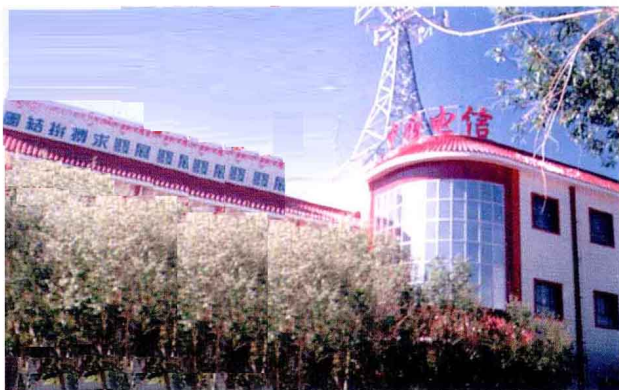
阿里地区电信大楼一角
