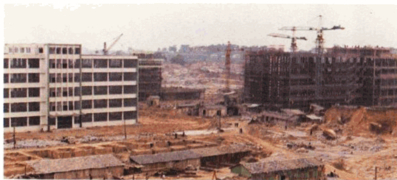
1.2. 湖里工業區 工地一角
