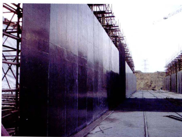
锅炉基础模板工艺 (齐热一期 2 \times 300\text{MW} )
