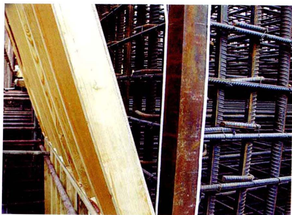
汽轮机基座大模板工艺 (包头一期 2 \times 600\text{MW} )
