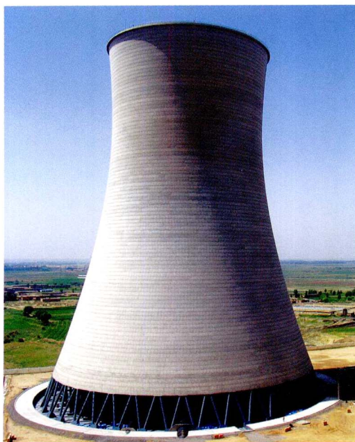
2号冷却塔外观工艺 (包头一期 2 \times 600\text{MW} )
