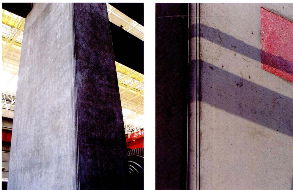
框架柱清水混凝土质量工艺 (长沙 2×600MW)
