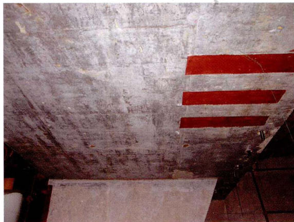
汽轮机基座清水混凝土工艺 (齐热一期 2 \times 300\text{MW} )
