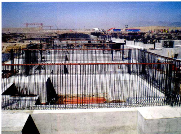
主厂房基础框架清水混凝土工艺 (包头土右 2×600MW)
