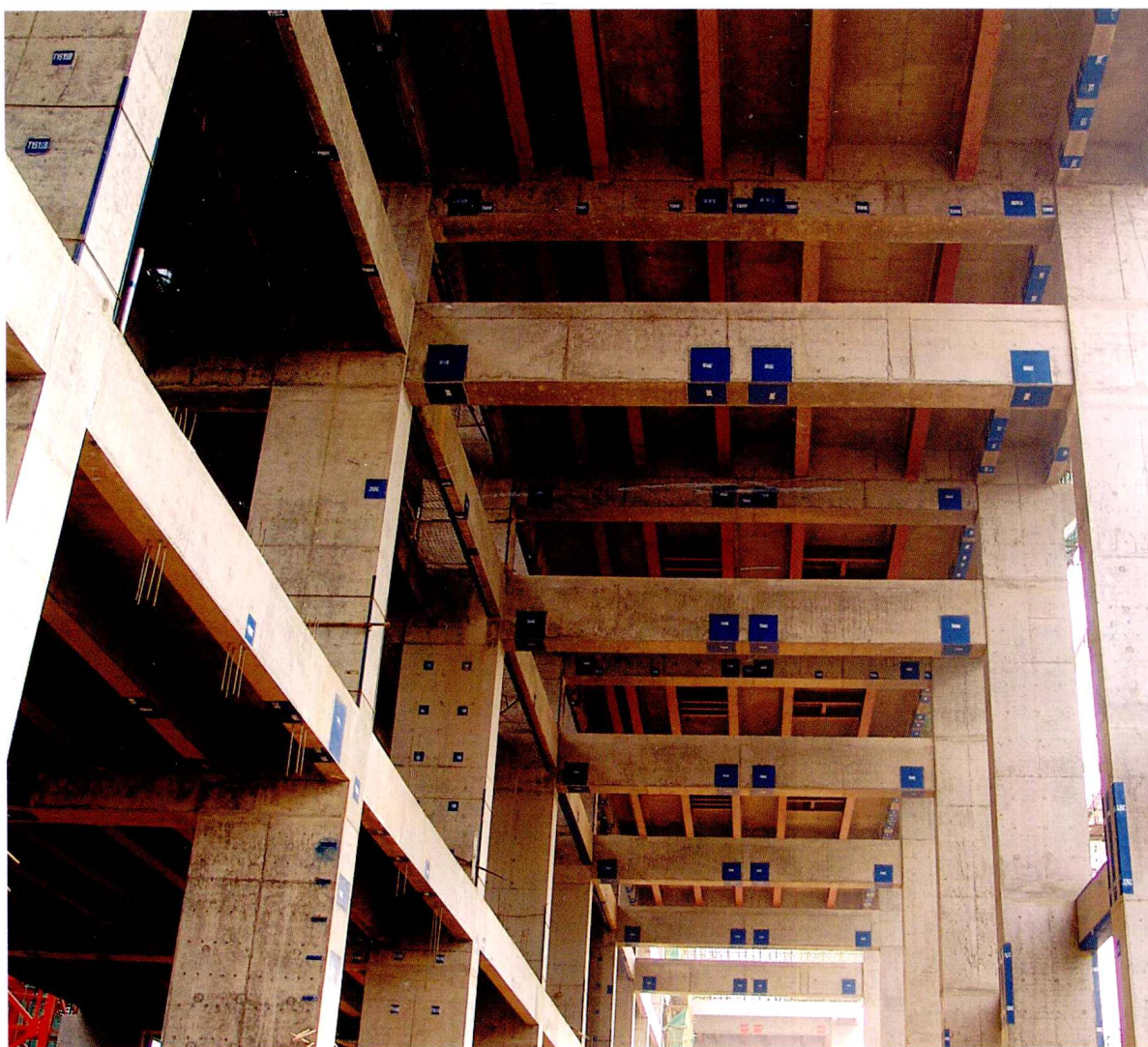
主厂房 CD 列框架清水混凝土施工工艺 (贵港一期 2 \times 600\text{MW} )
