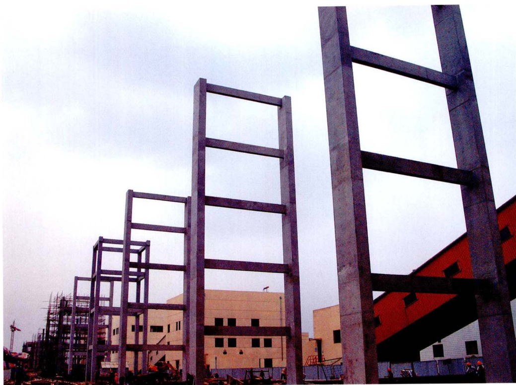
输煤栈桥清水混凝土工艺 (邹县四期 2 \times 1000\text{MW} )
