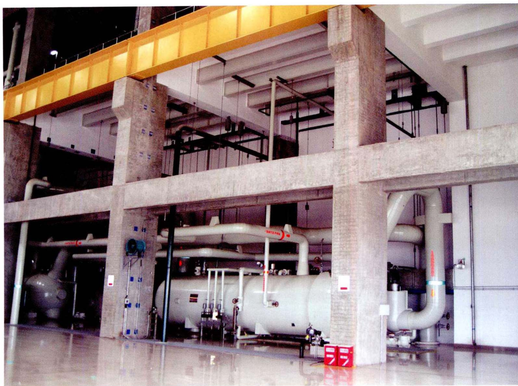
主厂房运转层框架清水混凝土施工工艺 (贵港一期 2 \times 600\text{MW} )
