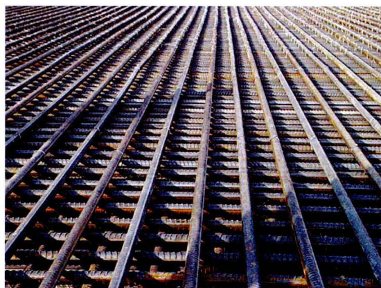
汽轮机基础底板钢筋绑扎工艺 (包头一期 2×600MW)
