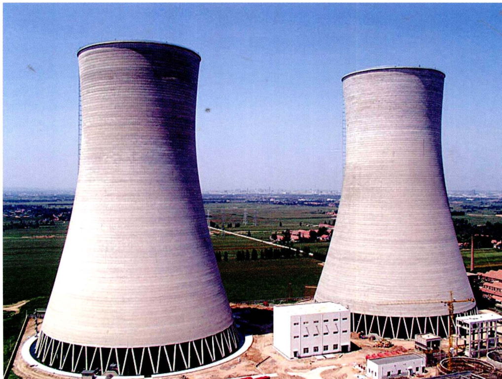
冷却塔外观整体效果 (潍坊二期 2 \times 670\text{MW} )
