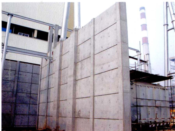
主变压器防火墙清水混凝土工艺 (邹县四期 2 \times 1000\text{MW} )
