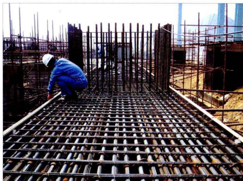
锅炉基础钢筋绑扎工艺 (可门一期 2×600MW)
