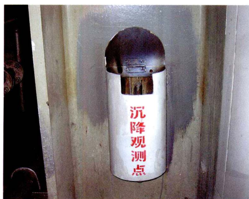
锅炉钢柱沉降观测点保护盒 (包头一期 2 \times 600\text{MW} )
