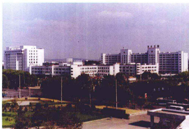
■医院主建筑群
