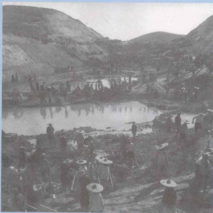
运河总干渠北段最艰巨的新屋仔七级平台
