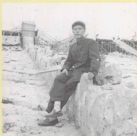
广东省水电厅工程师何多基，是鹤地水库、雷州青年运河工地副总指挥。他主持工地的勘测、规划设计、施工等工作。图是何多基总工程师在溢洪道工地。
