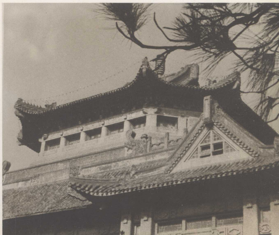
傳統建築造型之圖書館
