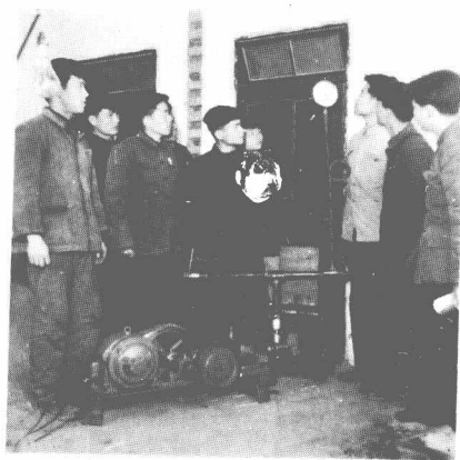
化机 58 年级同学参加生产高压试压泵, 同学们正在测试压力
