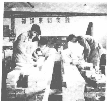
陶瓷 62 年级同学自己动手建隧道窑
