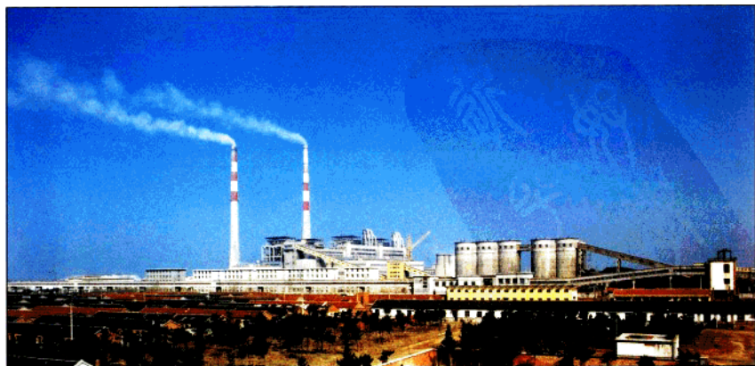
山東龍口發電廠全景 (該工程獲國家級優秀設計銀質獎) 西北電力設計院
