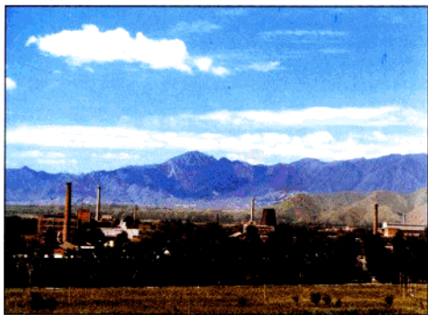
圖為五十年代在蘇聯技術援助下，於我國北京郊區建成的第一座核科研基地——中國原子能研究所的實驗性重水反應堆、實驗性核化工設施及回旋加速器廠房外景。葉德燦同志當時為該工程中國設計方的設計總工程師，參與領導並主持工程設計。
