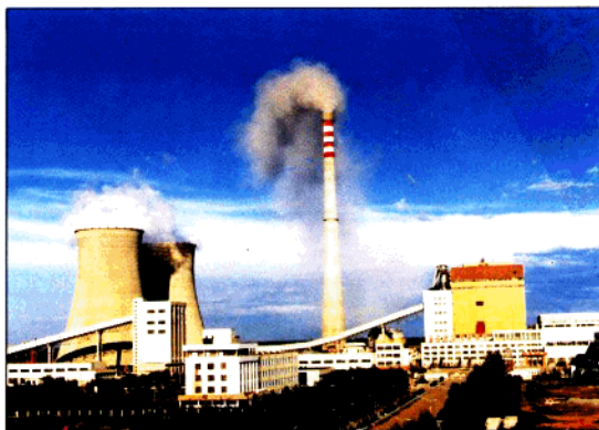
富拉爾基第二發電廠
