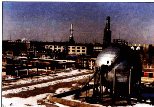
莎中油氣處理廠一角：包括年處理500萬噸原油穩定裝置，日處理30萬方淺冷和60萬方深冷油田氣分離裝置，日發電2.3萬千瓦燃機電站各一座。85年開始設計、建設，87年底投產。
