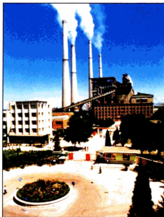
唐山陡河電站 （總容量為1550MW）
