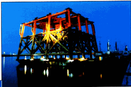
圖爲“濟海306”導管架下水駁船正在配合海上鑽井平台施工，完成大型導管架的通輪任務。
