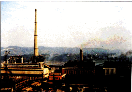
重慶電廠全景
