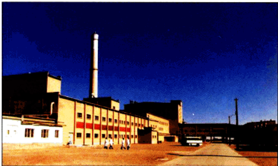
圖為六十年代末期自力更生建成投產的中國第一座以萃取法為新工藝流程的現代化的核燃料後處理廠主工藝廠房外景。葉德燦同志當時任院總工程師，領導主持了該工程科研攻關及工程設計。
