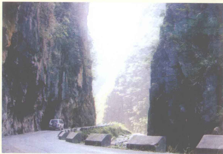
道真至务川公路穿过旧城一线天
