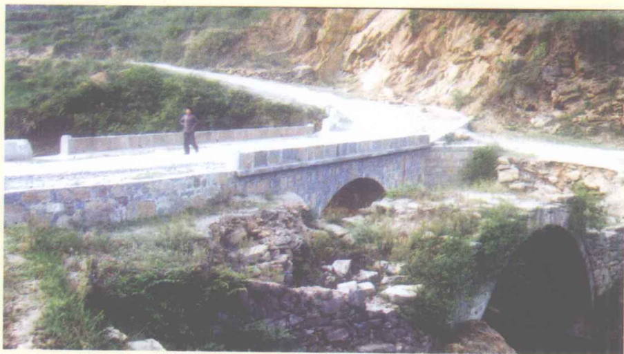
槐溪至棕坪通乡 油路改造
