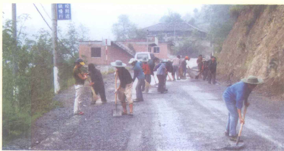
巴渔至阳溪公 路改造施工现场
