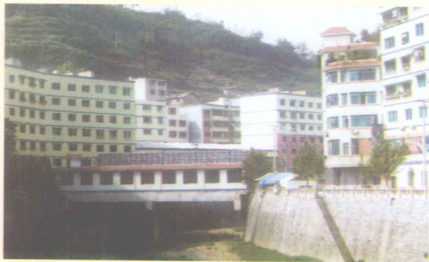
跨玉溪河人行桥—— 玉银桥（2004年）
