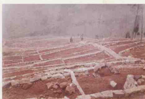
2001年，太平乡古楼村五马石坡耕地治理现场。（太平乡 提供）
