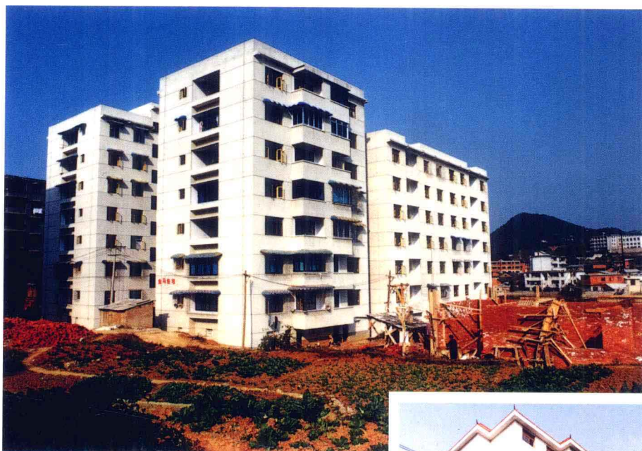
金马房地产开发公司正在修建的安居工程
