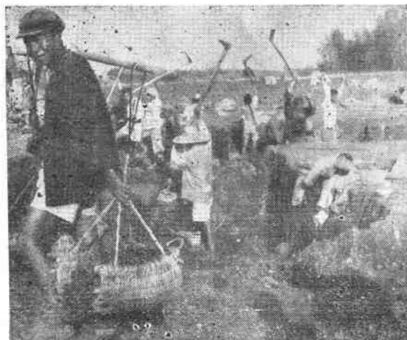
(施一綫—照—16—9) 用鋤頭挖土及大土箕運土情況。
