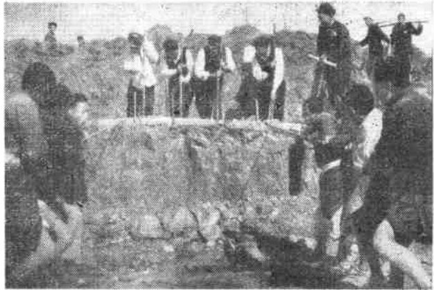
(施一綫—照—16—10) 挖硬土用整方辦法操作情況。
