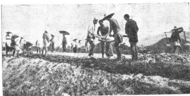
(施一綫—照—16—4) 分層填土四人打夯情況。
