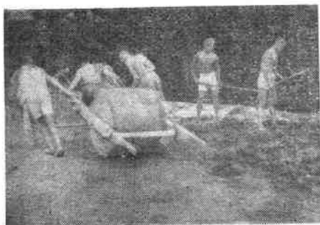
(施一綫—照—16—5) 分層填土四人滾壓情況。
