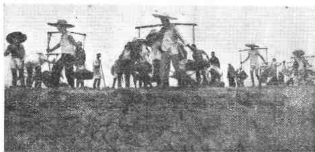
（施一綫—照—16—1）路基分層填土情況之一。
