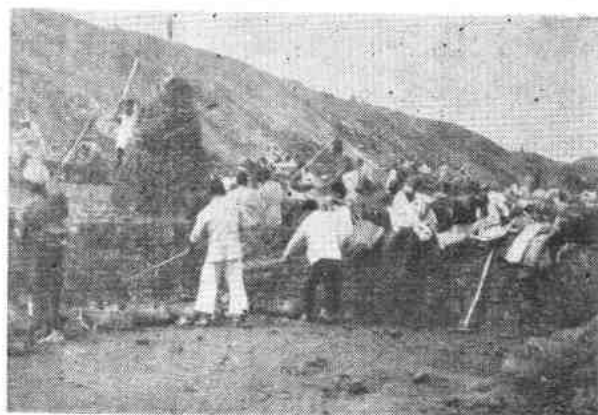
(施一綫—照—16—8) 用鋤頭挖土情形。
