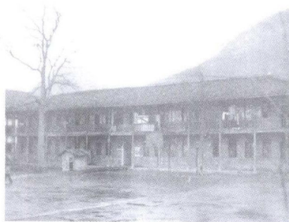
▲ 德江中学学生运动罢课旧址 (张安余摄影提供)
