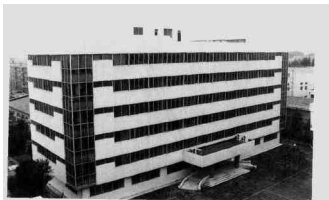
高档数控国家工程研究中心大楼
