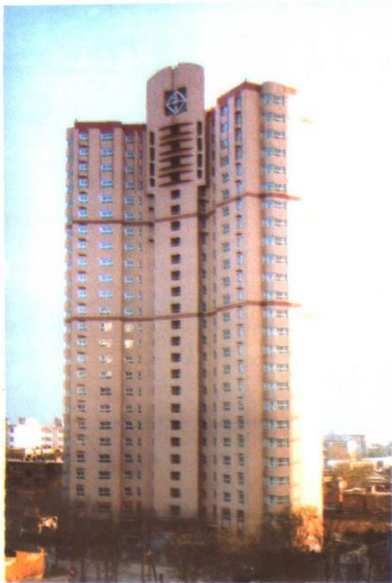
◀ 省会筑巢引凤科技兴冀工程 —石家庄博士专家楼
