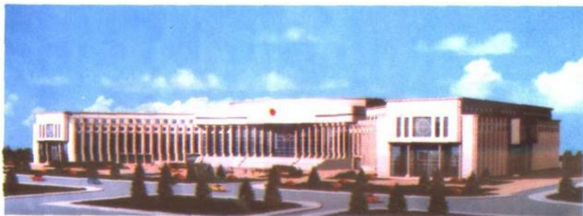
▼ 省会最大的工程—市一宫综合改造工程
