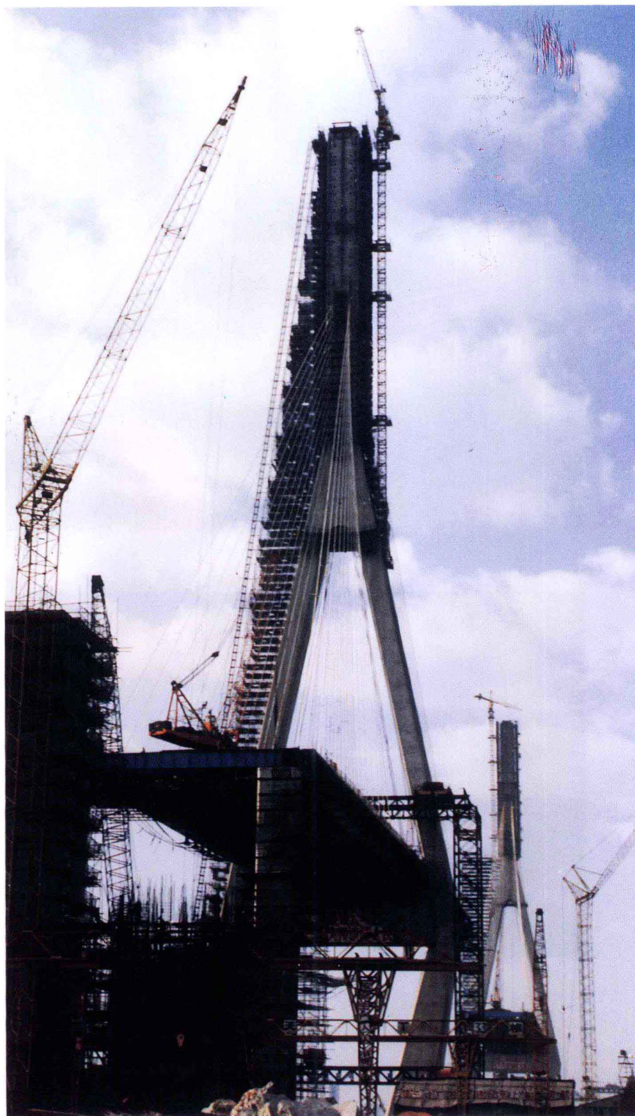
建设中的杨浦大桥
