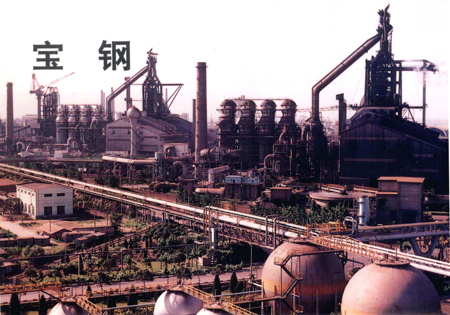
图为宝钢的一号、二号高炉及正在建设中的三号高炉。三座高炉均为 4000 米 3 级，为国内最大。
