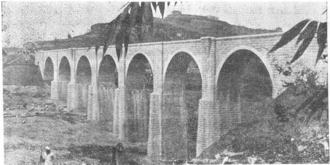
(施一橋一照—21—6) 壽溪河大橋全景。
