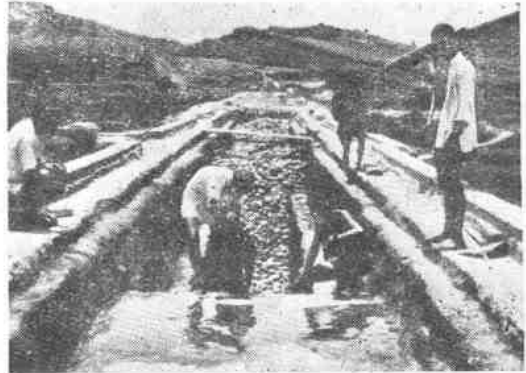
(施一橋一照—21—8) 壽溪河大橋拱頂鋪設防水層作業。
