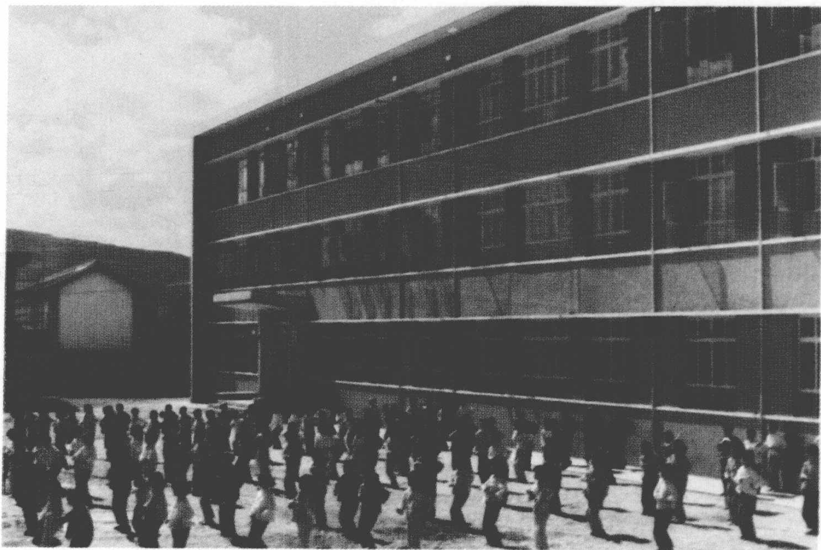
城关镇小学教学楼
