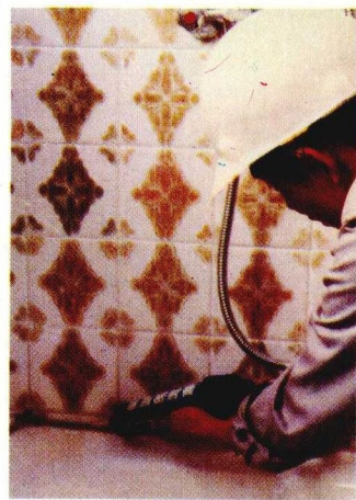
建筑密封膏施工图
